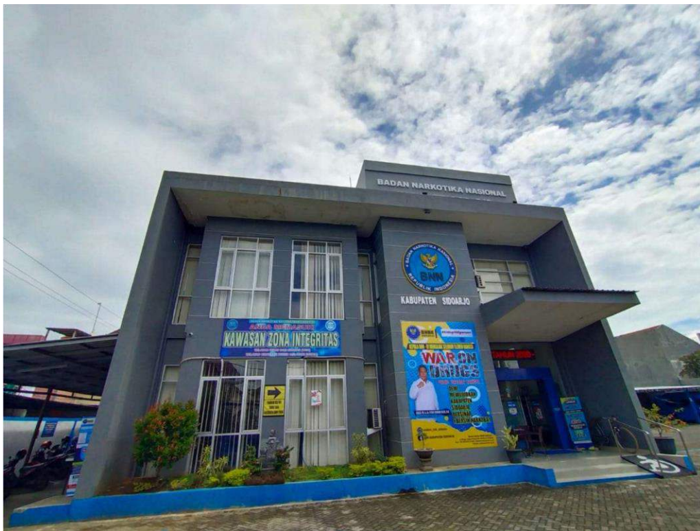
Gambar. 3. Bangunan Kantor BNN Kota Banjarmasin
